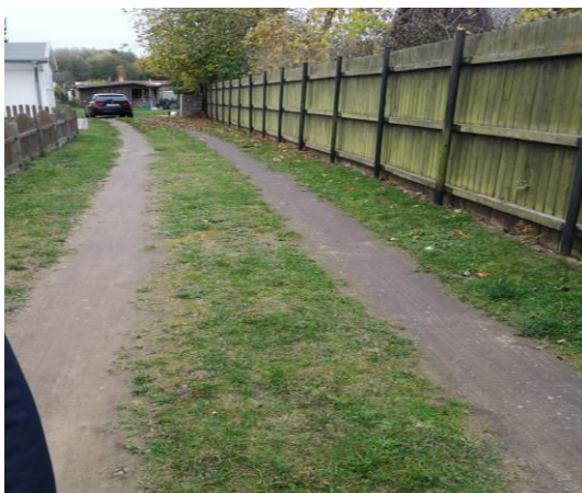
Abbildung 7 unversiegelter, stark verdichteter Weg
