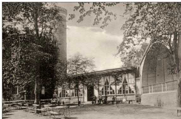
Der Bau des Belvedere-Schlösschens mit Anlagenlokal wurde 1873 begonnen und 1878 in Regie des Verschönerungsvereins vollendet. Bereits vorher bestand eine Konzertbühne.
