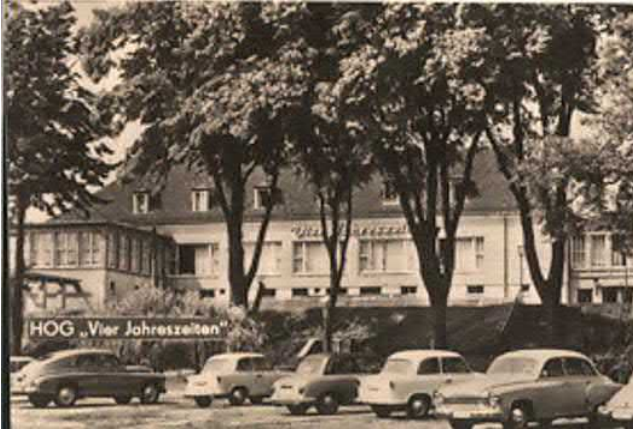
Ehem. Gaststätte „Vier-Jahreszeiten“
