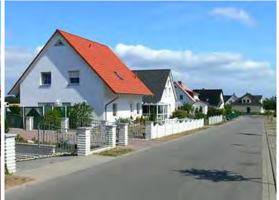
Neue Wohnhäuser, Baujahr nach 1990
