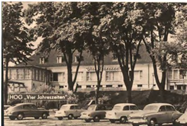
Ehem. Gaststätte „Vier-Jahreszeiten“
