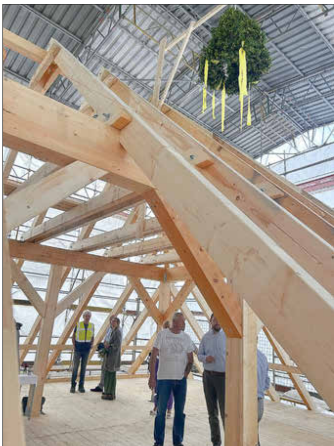
Richtkrone am neuen Dachstuhl.
