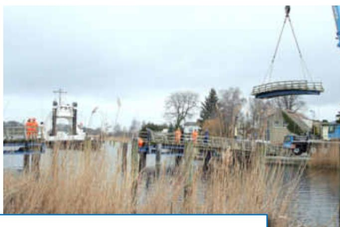
Am 10.03.2017 wurde das Eisenbahndampffährschiff „Stralsund“ aus dem Museumshafen geschleppt und trat seine kurze Reise in den Stadthafen an. Dafür war das Ausheben eines Segmentes der Amazonenbrücke erforderlich.
